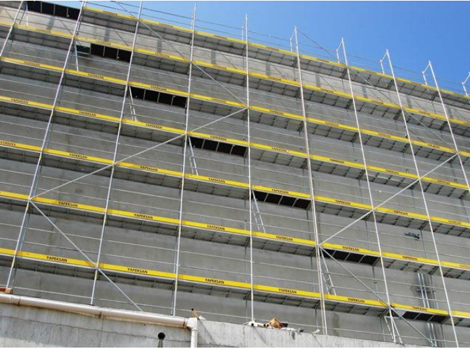
MARMARA PARK AVM _Kayı İnşaat
