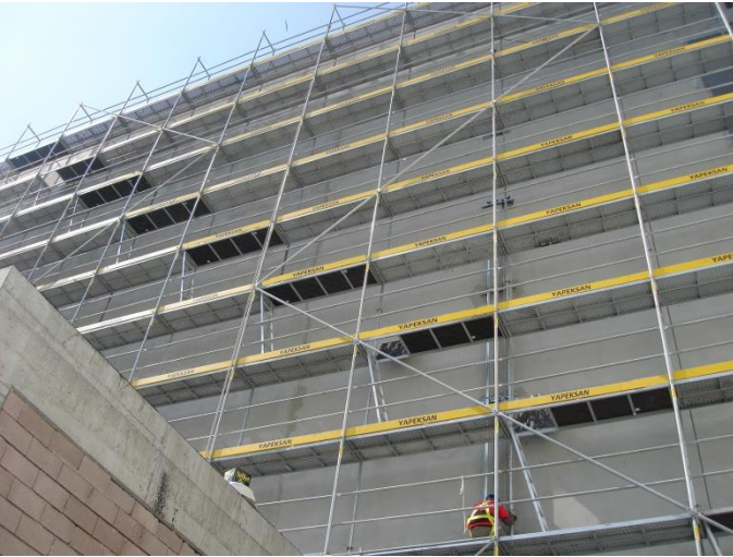
MARMARA PARK AVM _Kayı İnşaat
